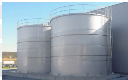
Наружные, отдельно стоящие емкости с объемом 1 млн литров
