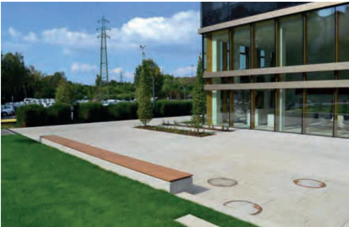
Projet: Enovos à Esch/Alzette Dalles en béton type Alinéa 75 x 50 x 12 cm et Elégance 45 x 30 x 12 cm, dalles sur mesure 100 x 30 x 6/12 cm, marches et bancs sur mesures . Projekt: Enovos in Esch/Alzette Betonplatten Alinéa 75 x 50 x 12 cm und Elégance 45 x 30 x 12 cm, Platten als Sonderanfertigung 100 x 30 x 6/12 cm, Stufen und Bänke als Sonderanfertigung.
