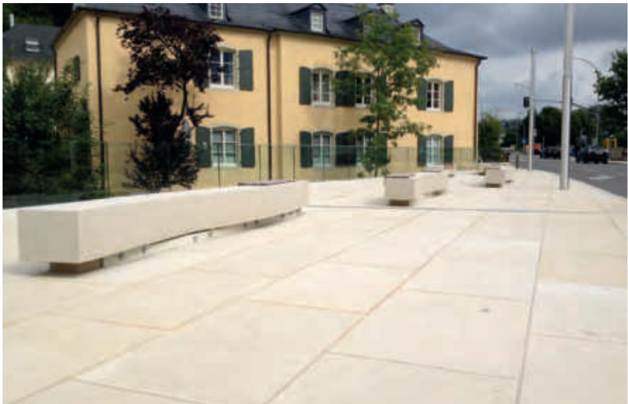
Projet: Centre de Hesperange Dalles en béton avec le relief de Heperange: 136 x 84 x 12 cm. Projekt: Zentrum in Hesperange Betonplatten mit Oberflächengestaltung von Hesperange: 136 x 84 x 12 cm.
