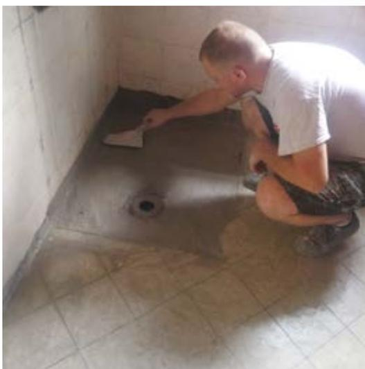
Preparazione della platea. La zona prima occupata dal vecchio piatto doccia viene completata e livellata con speciale massetto di sabbia e cemento a rapida asciugatura. Il massetto crea stabilità e garantisce impermeabilità al di sotto del nuovo piatto doccia
