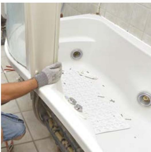
Rimozione della vecchia vasca: gli operai rimuovono la vecchia vasca da bagno e il suo cassone di contenimento, senza rompere le piastrelle circostanti preservandole
