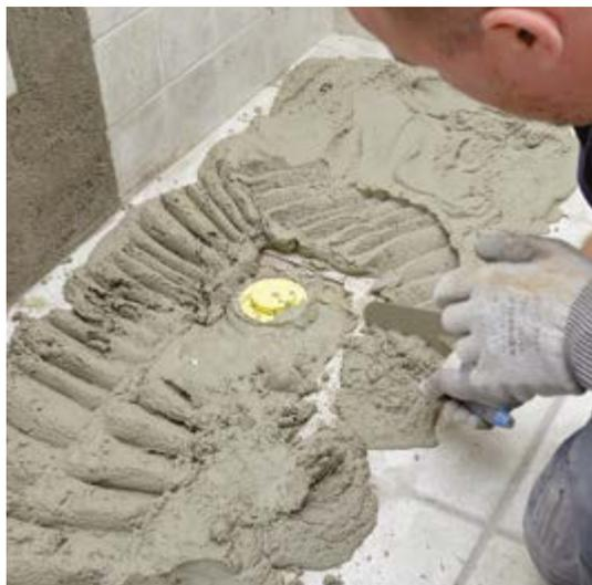
Preparazione della platea. La zona prima occupata dalla vasca viene completata e livellata con speciale massetto di sabbia e cemento a rapida asciugatura. Il massetto crea stabilità e garantisce impermeabilità al di sotto del nuovo piatto doccia
