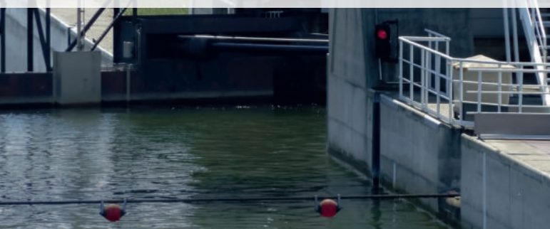
Notstopp-Fangseil-Dämpfung vor Schleuse // Emergency stop rope damping in front of water lock
