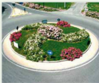
Progettazione e realizzazione rotonda di rappresentanza in località Cavazzoli
