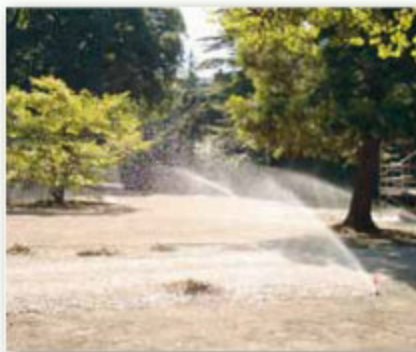
Realizzazione, prove e funzionamento dell'impianto con irrigatori dinamici nei Giardini Pubblici di Reggio Emilia
