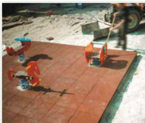
Posa di pavimentazione antitrauma e giochi a molla in una scuola materna di Venezia
