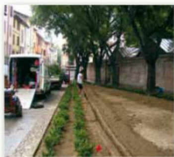
Scavo con catenaria per la realizzazione di impianto irriguo
