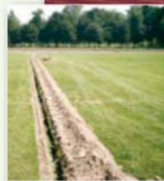
Realizzazione dell'impianto d'irrigazione in campo di atletica successivamente rigenerato
