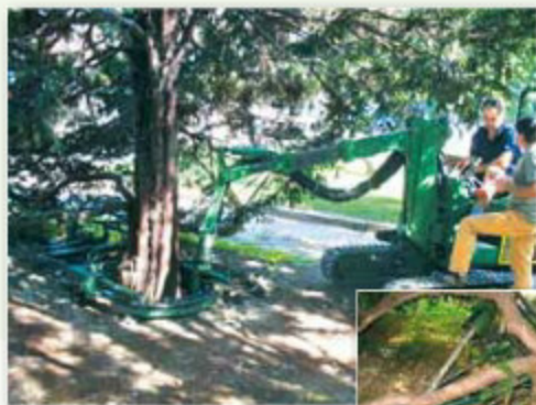
Preparazione al trapianto di grandi tassi con uso di macchina zollatrice - RE
