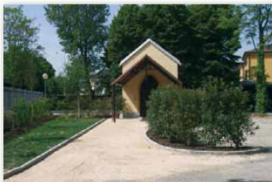
Recupero area della Cappella di culto della Casa Protetta in Castelnuovo Sotto
