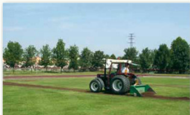
Lavorazioni di ripristino del manto erboso
