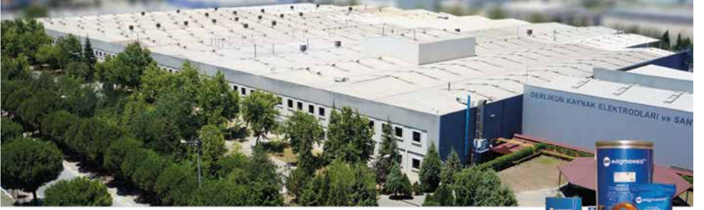
Kaynak Tüketim Malzemeleri Fabrikası Organize Sanayi Bölgesi 2. Kısım - MANİSA
