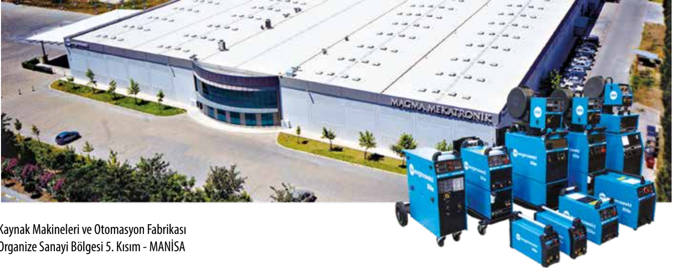
Kaynak Tüketim Malzemeleri Fabrikası Organize Sanayi Bölgesi 2. Kısım - MANİSA
