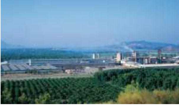
Dalaman Cellulose and Paper Factory, Muğla/Turkey Dalaman Selüloz ve Kağıt Fabrikası İnşaatı, Muğla
