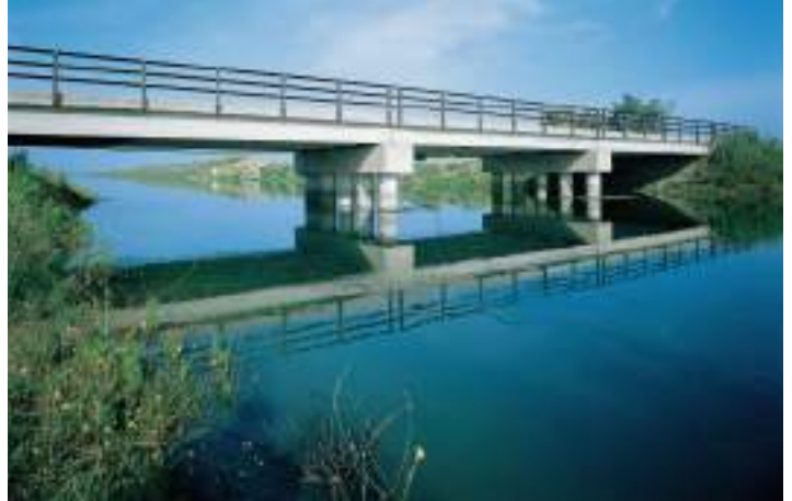
Seyhan Irrigation System, Adana/Turkey Seyhan Sulaması İsale Kanalı İnşaatı, Adana
