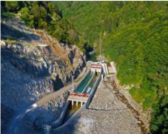
32,9 MW Arpa HEPP Project, Artvin/Turkey 32,9 MW Arpa HES Projesi, Artvin
