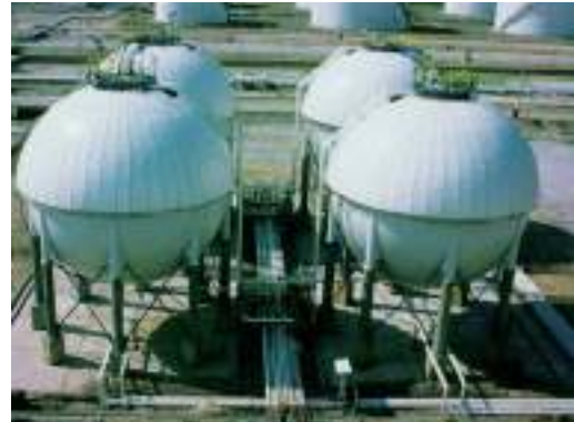
Aliğa Petrochemical Facility, Manufacturing and Erection of Spherical Tanks, İzmir/Turkey Aliğa Petrokimya Tesisi Küresel Tankların İmalatı ve Montajı, İzmir
