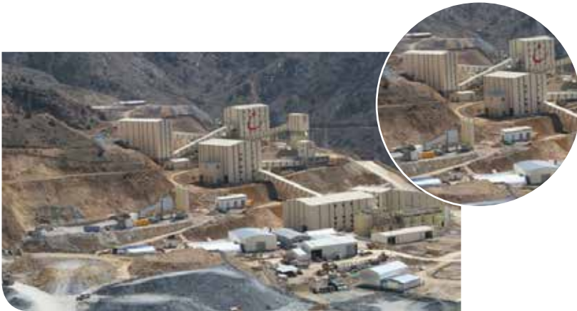
Özel Silindirle Sıkıştırılmış Beton (RCC) –Baraj Santrali Projesi
